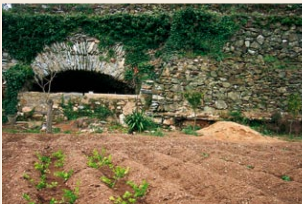
La mina recull les aigües que abasteixen la font del Portal i el dipòsit del poble
